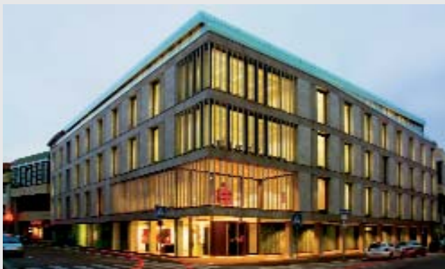
Die Hauptstelle der Sparkasse in Würzburg, Hofstraße.
